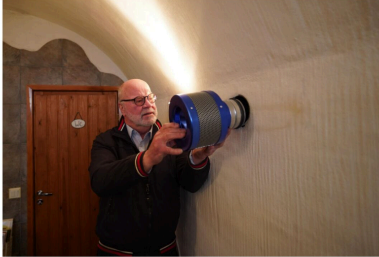
Jari Ruusunen esittelee säteilysuojajärjestelmää, joka on rakennettu Holvisaunojen toimipisteeseen.
